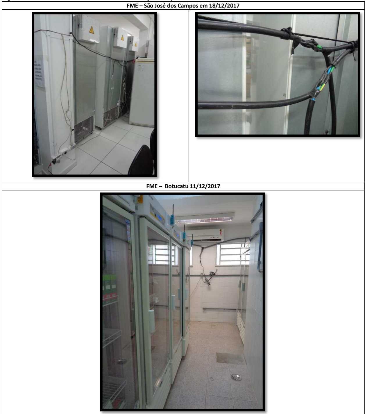
Figura 10 – Áreas de armazenamento com fiações expostas
