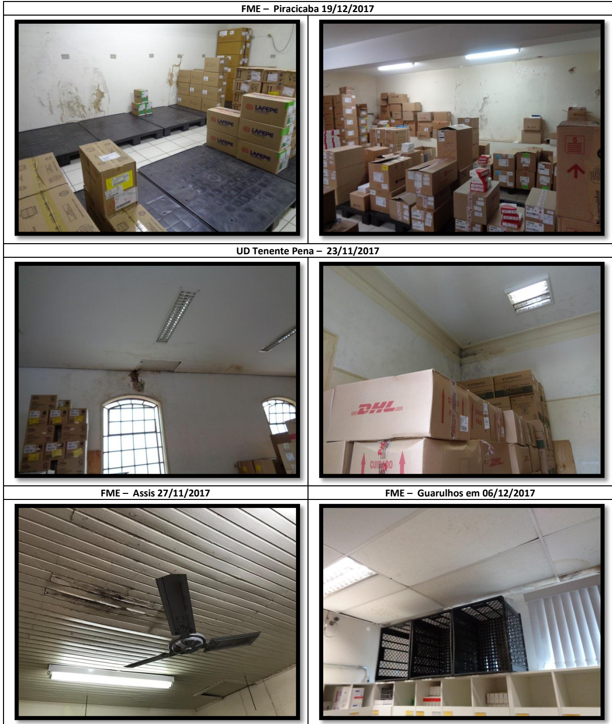
Figura 9 – Áreas de armazenamento com infiltrações
